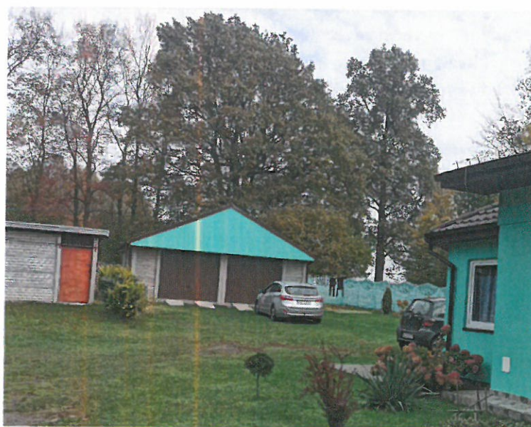
Zdjęcie 11: Budynek gospodarczy z zewnątrz..
