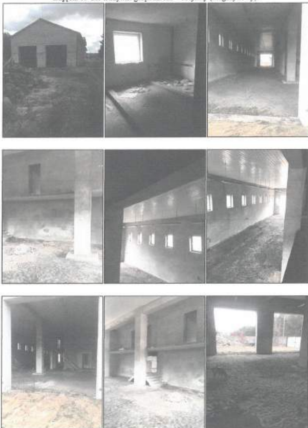
Zdjęcia 19-28: Budynek gospodarczo – socjalny (magazynowy).
