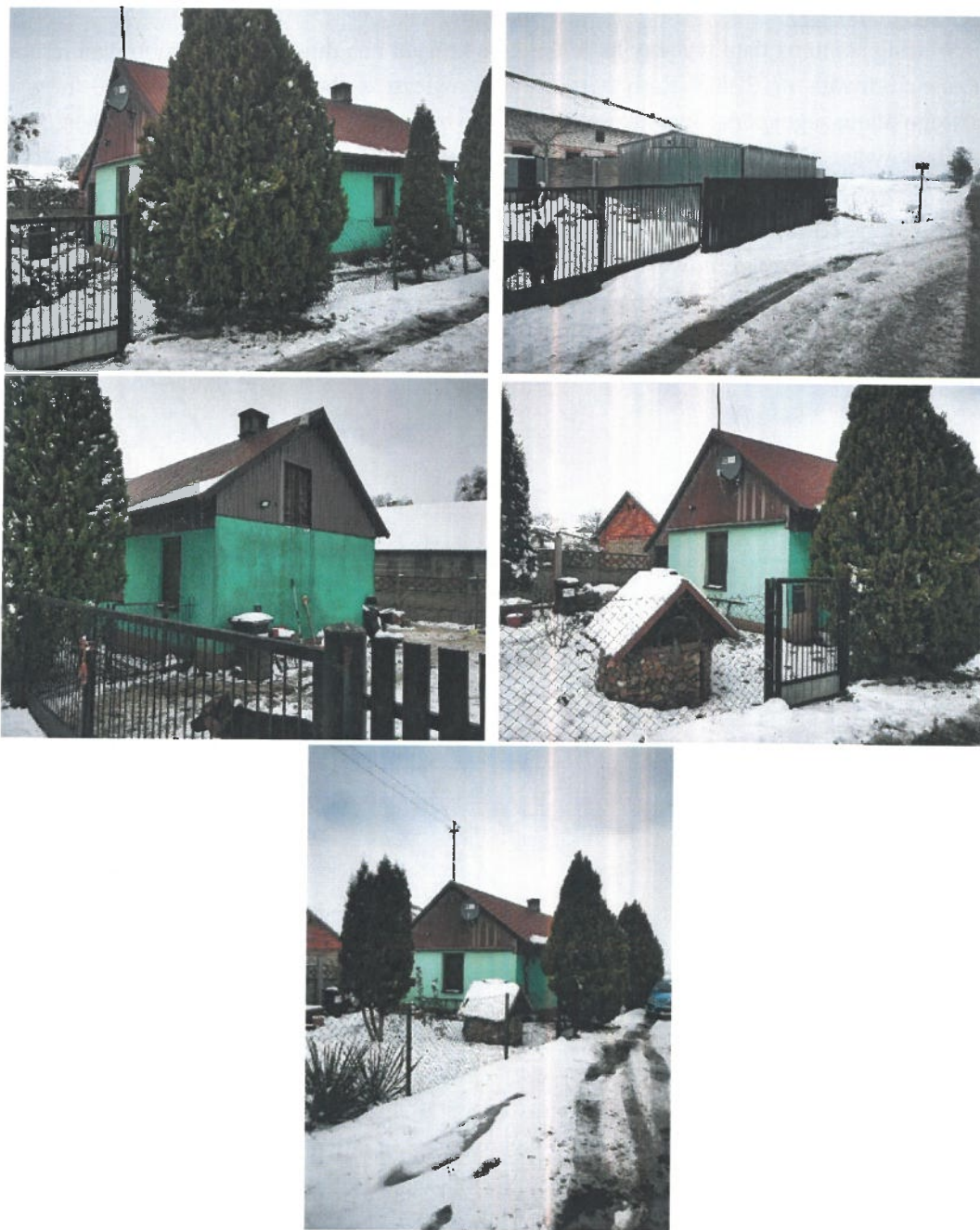
Zdjęcia 2-6: Zagospodarowanie terenu i zabudowania na przedmiotowej nieruchomości z zewnątrz.
