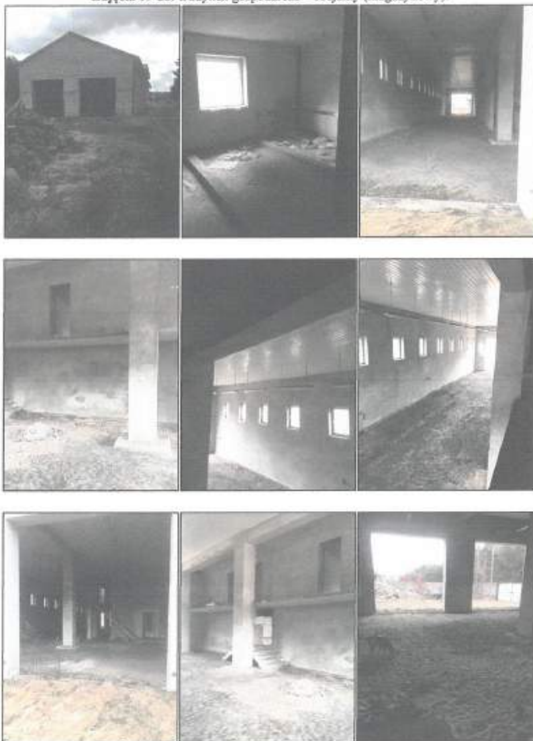
Zdjęcia 19-28: Budynek gospodarczo – socjalny (magazynowy).
