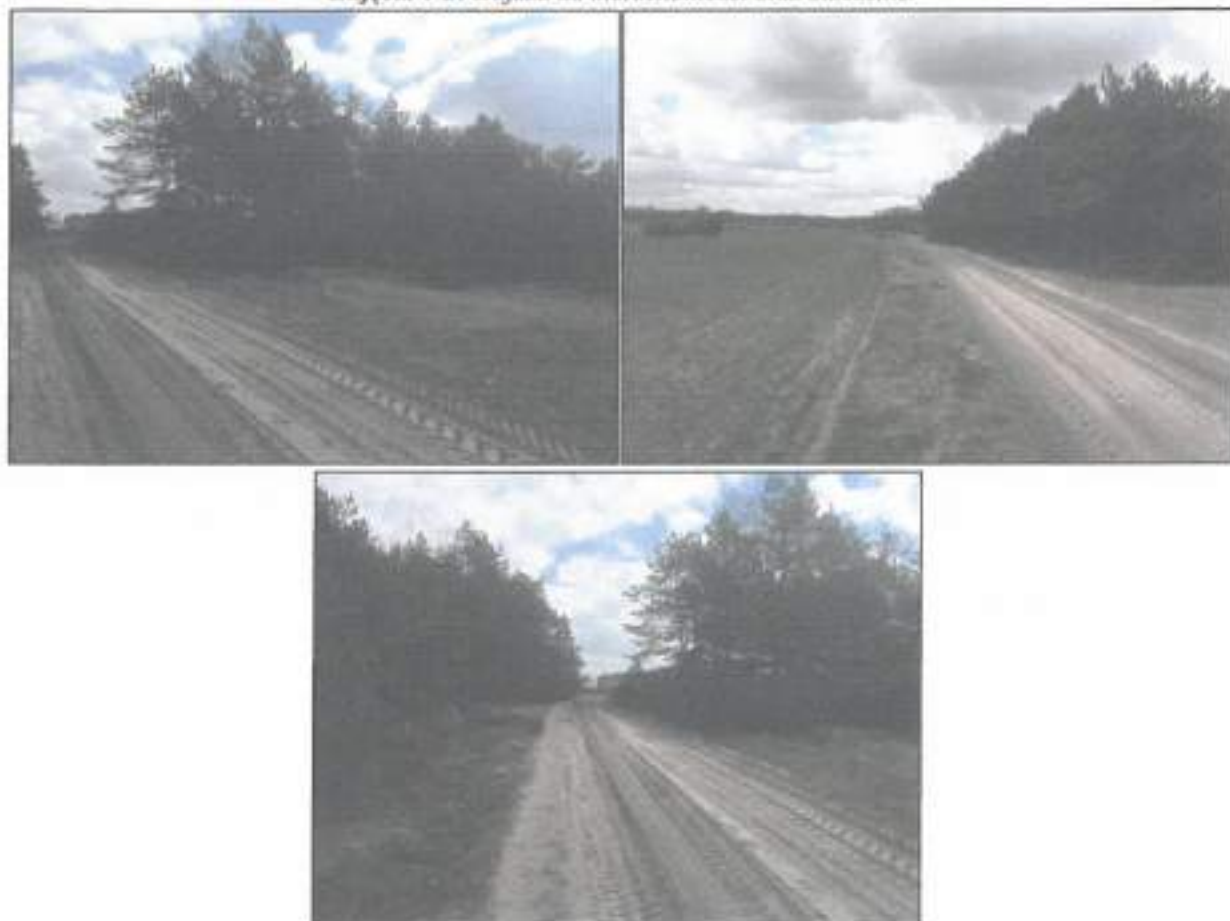
Zdjęcia 1-3: Dojazd do nieruchomości oraz otoczenie.
