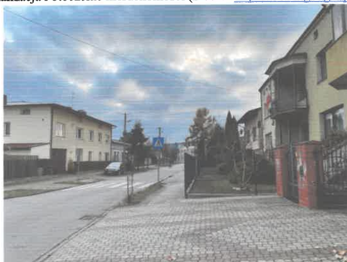
Widok drogi dojazdowej i sąsiedztwa
