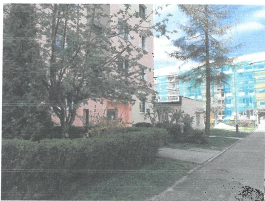
wejście do budynku
