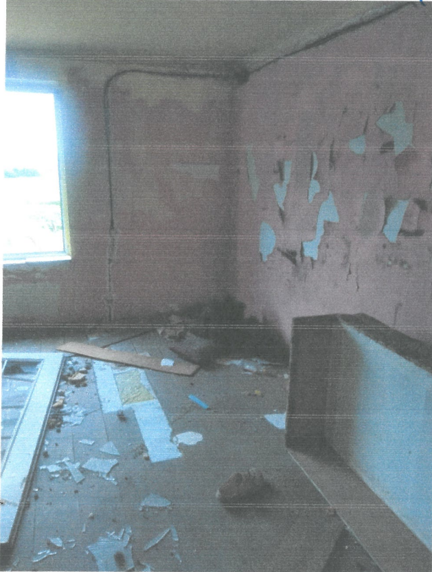
wyrwana instalacja elektryczna
