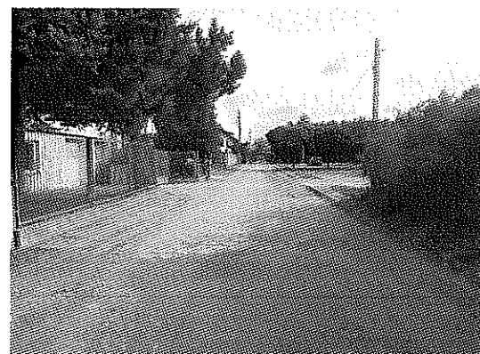
ogrodzenie brak wjazdu od ulicy na działkę 29/4
